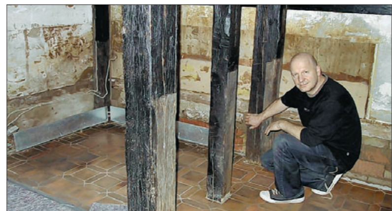
Komplett zerstört wurde beim Hochwasser der Gastraum der „Kupferpfanne“. Trotzdem richtet Gerd Merkel den Blick nach vorne. Fotos: Hegele
