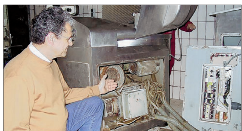
Mit modernster Elektronik sind die Maschinen von Metzgermeister Günter Weiler ausgestattet – und noch immer sind die Schaltkästen feucht.
